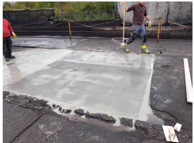
Carbonbewehrung_04.jpg Fotocredit: Firma Koch Bauinstandsetzung
